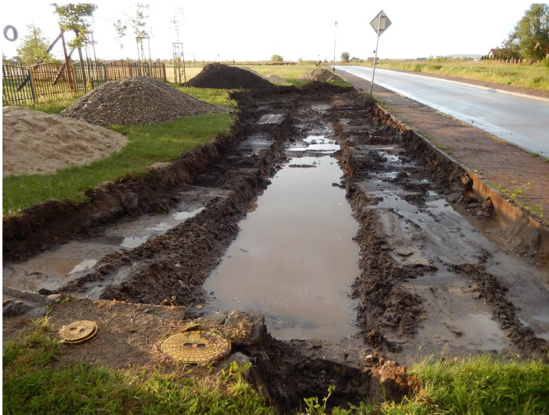
Fot. Ogród deszczowy w budowie
